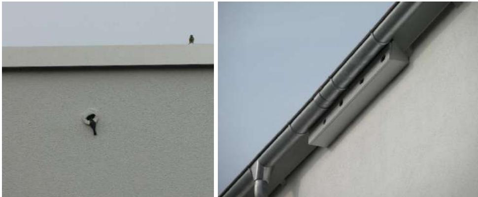
Abbildung 3-33: Verputzter Einbaustein (links), Nistkastenkonstruktion im Traufbereich (rechts) (© Jana Lübbert)
